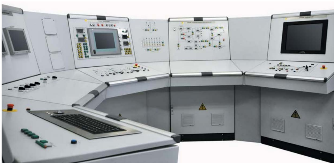
Рисунок 1.3 – Пульт керування автоматизованого робочого місця системи контролю технологічних параметрів технологічного обладнання енергоблоку електростанції
