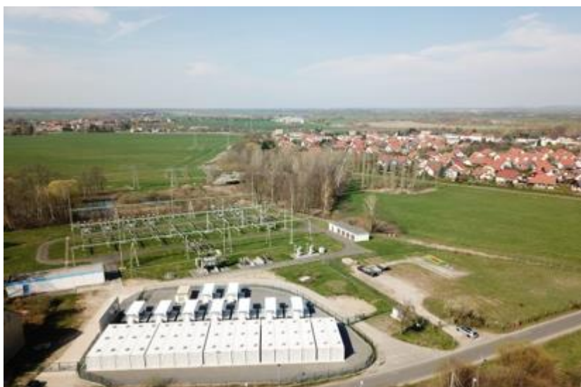
Рисунок 1.10 - Великий накопичувач енергії на основі свинцево-вуглецевих акумуляторів
