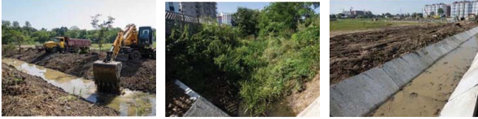
Рис. 1. Розчистка русла р. Млинівка та облаштування каналу подачі води
