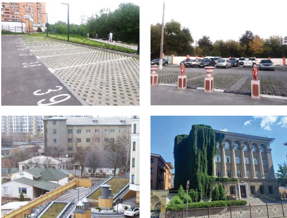
Рис. 6. Зелений дах підземного паркінгу, зелена парковка, зелена стіна
