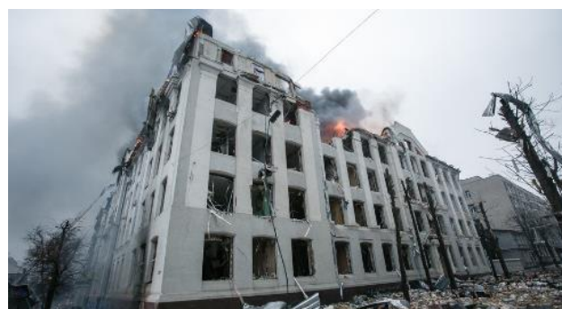
Будівля економічного факультету Каразінського університету після атак росії
