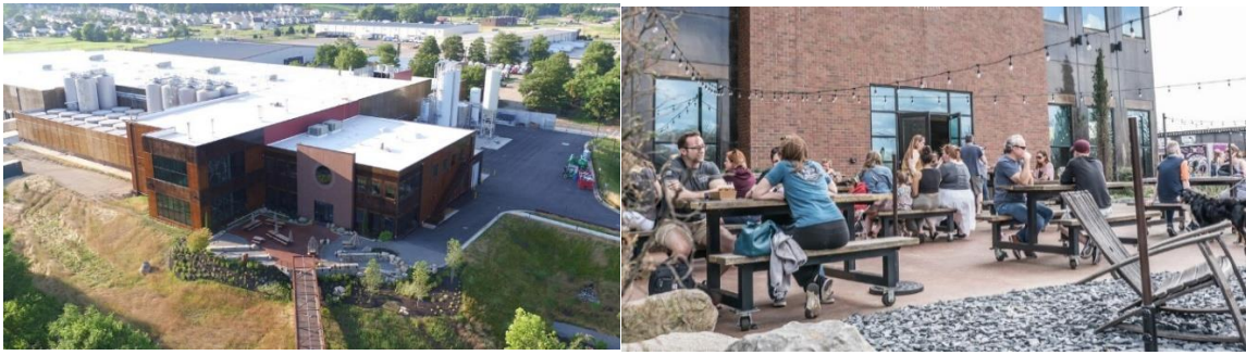
Рис. 2.10. Stone Brewing Production Facility, Richmond, Virginia, США (2018 рік). Сучасний виробничо-логістичний комплекс пивоварні Stone Brewing [29]
