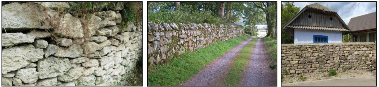
Фото 23. Метод будівництва «суха кладка».
