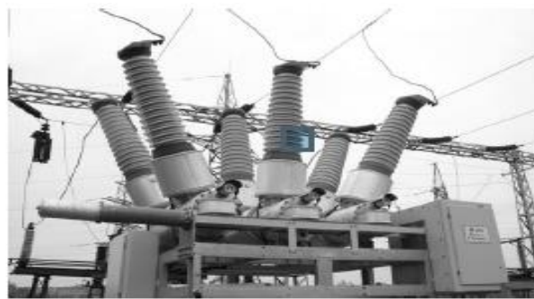
Рисунок 1.1 – Елегазовий вимикач
