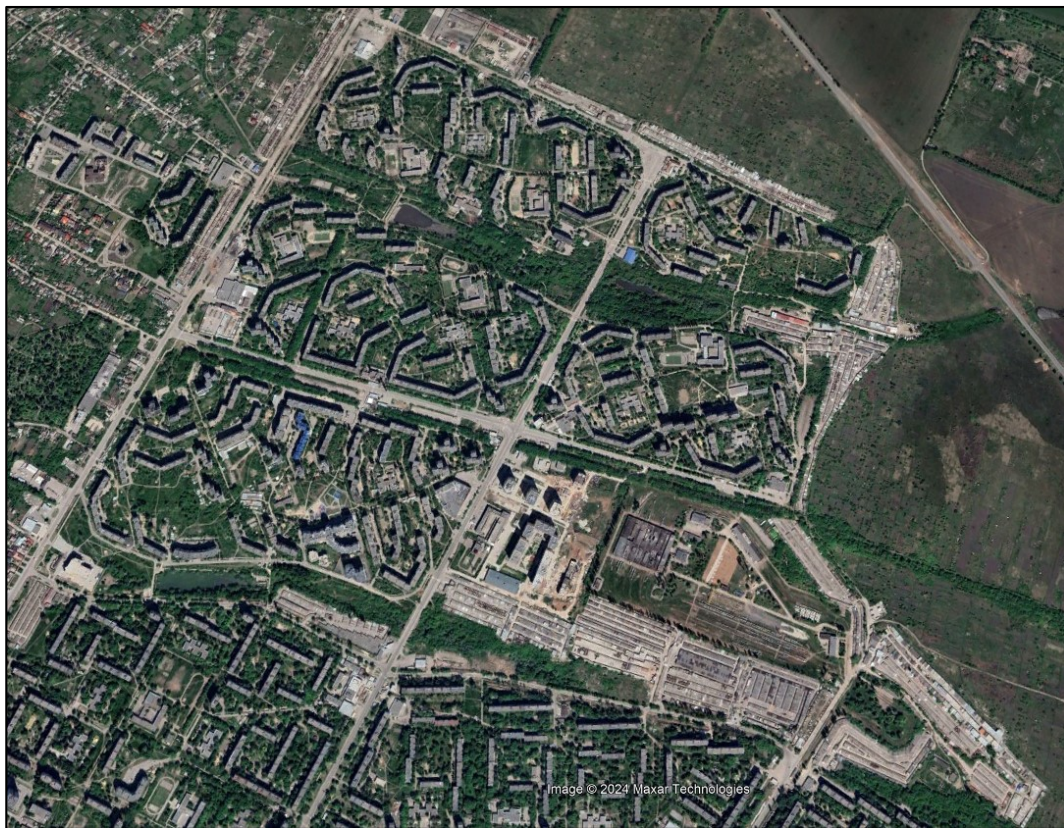
Рис.3.12. Пошкоджені/зруйновані будівлі району Північна Салтівка з супутникового знімку
