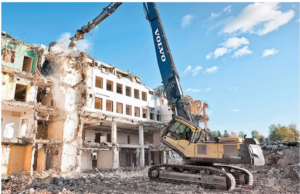
Рисунок 2.14. - Екскаватор нового покоління (версія HR) компанії Volvo Construction Equipment – мод. EC480E
