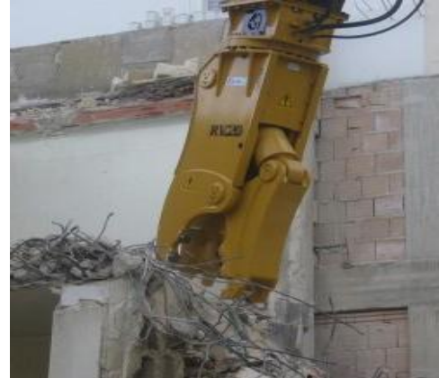
Рисунок 1.9 – Гідроножиці з одним гідроциліндром.
