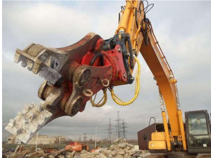
Рисунок 1.7 - Екскаватор, оснащений гідроножницями
