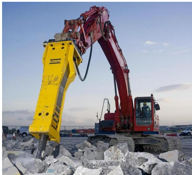
Рисунок 1.6 - Екскатор, оснащений гідромолотом
