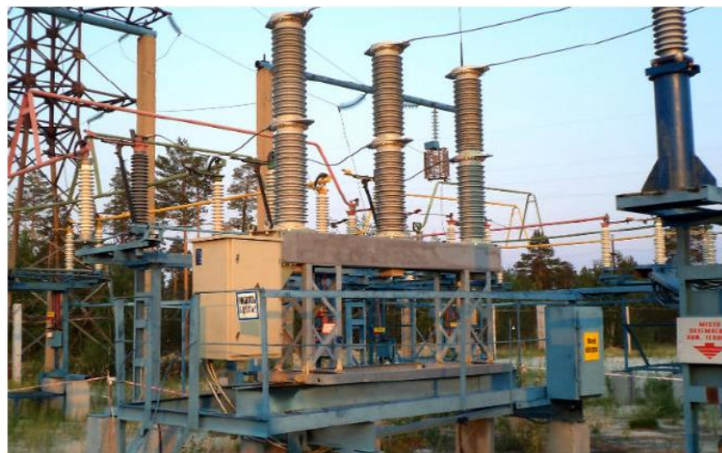
Рисунок 2.3 – Вид зовні вакуумного вимикача типу ВРС-110
