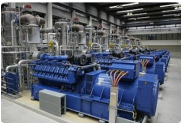
Рисунок 1.3 – Міні-ТЕЦ на пелетах з деревини
