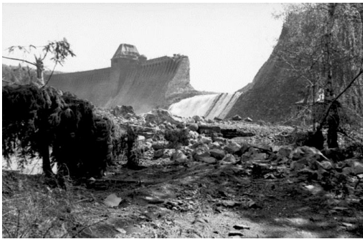
Рис.2.3 Пошкодження, завдані нальотом Дамбастерів на дамбу Мене, 1943 рік [73]
