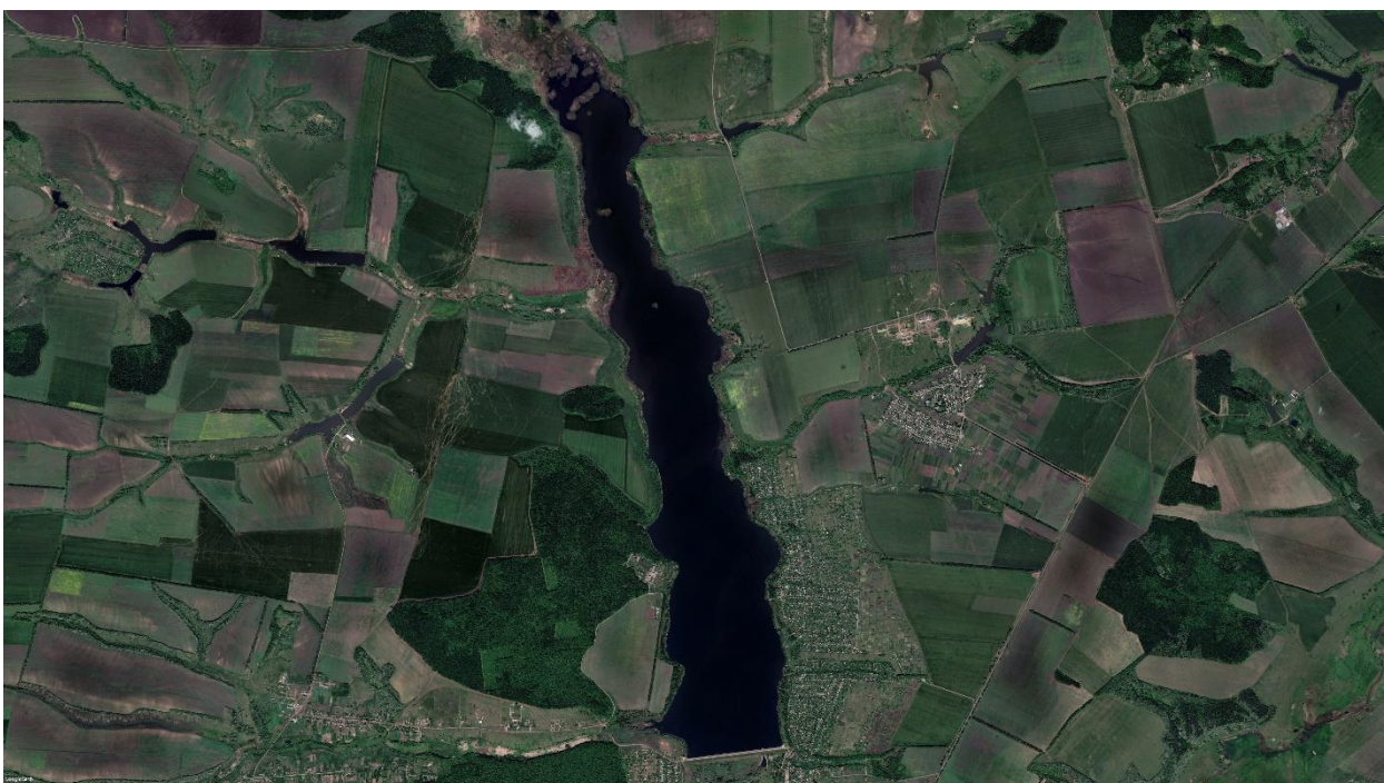
Рис. 3.1.3. Трав'янське водосховище та прилеглі території станом на 06.2022
