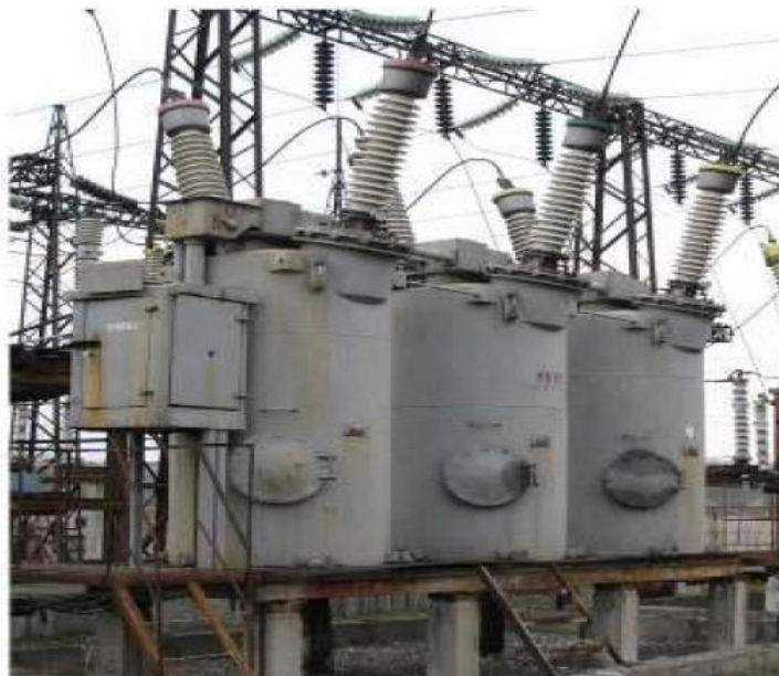
Рисунок 2.1 – Зовнішній вигляд масляного вимикача
