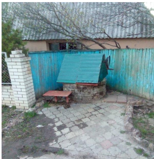
Рис. 2.4 – Колодязь № 2 на вулиці Різдвяна 18
