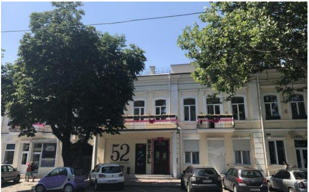
Рис. Б.2 Вхід до ресторану готелю «Hotel 52»
