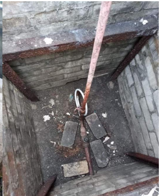
Рис. 2.10 – Залягання водопровідної труби
