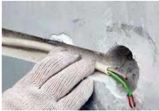
Рис. 6.5. Електропроводка в штробі
