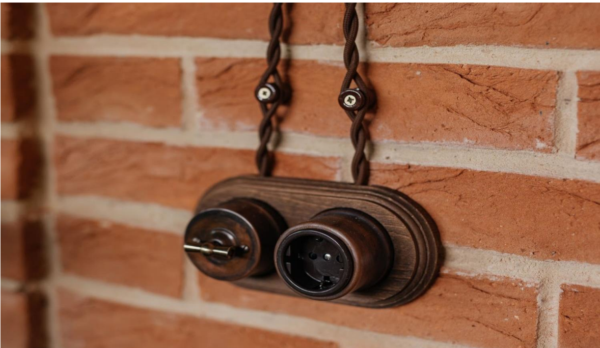
Рис. 6.2. Відкрита проводка на ізоляторах
