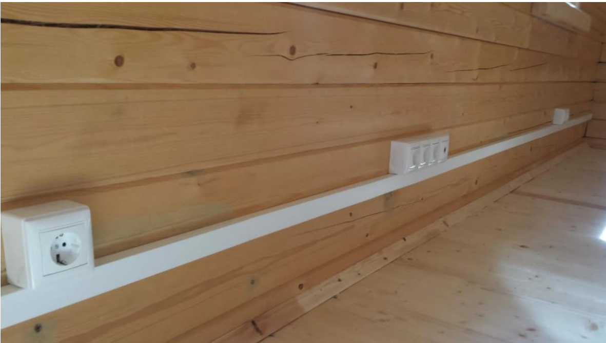
Рис. 6.4. Електропроводка в коробі
