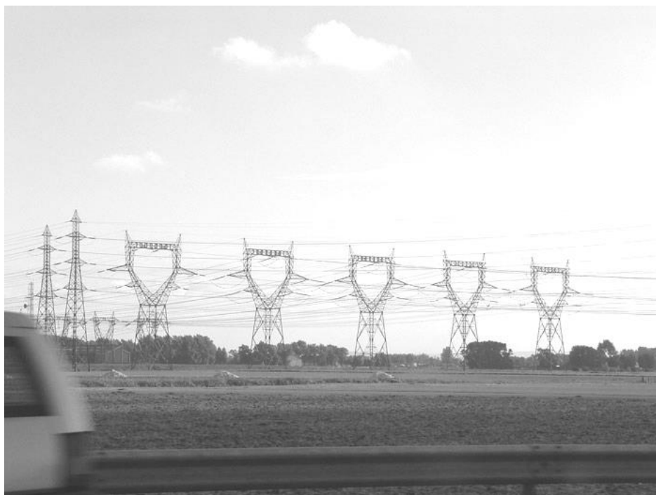
Рис. 1.6. Багатоланцюгова ПЛЕП (опори типу «чарка»)
