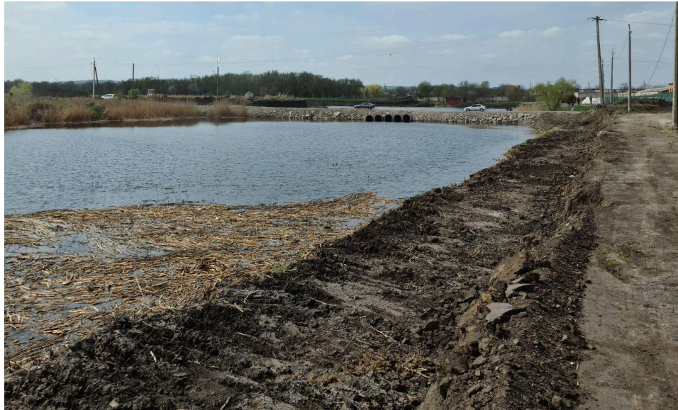
Рис. 3.15. Розкопаний беріг Мертвоводу та насипна переправа
