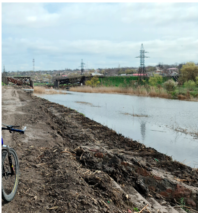
Рис. 3.13. Стан берегу річки Мертвовод, після проведення інженерних робіт, станом на 16 квітня 2022 року
