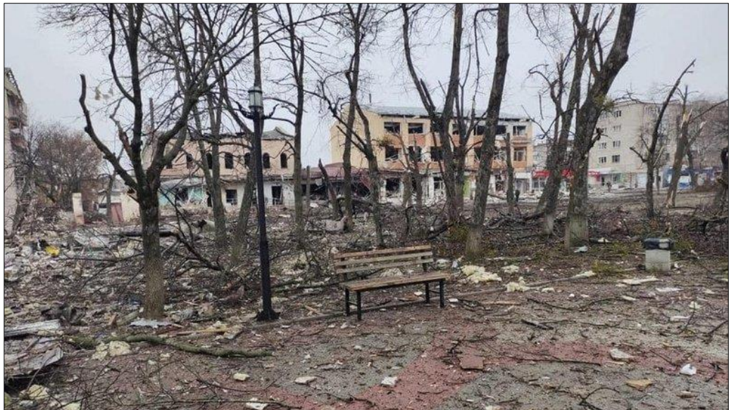
Рис. 3.7. Зруйнований центральний район міста Ізюм [18]
