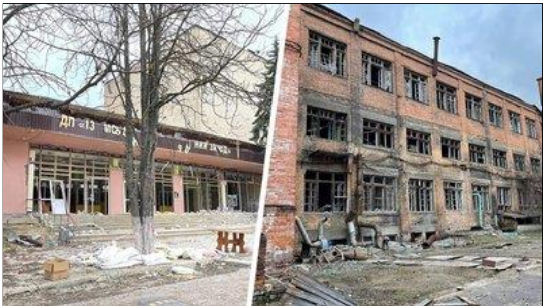
Рис. 2.17. Зруйнований приладобудівний завод в місті Ізюм внаслідок бомбардування рф [22]
