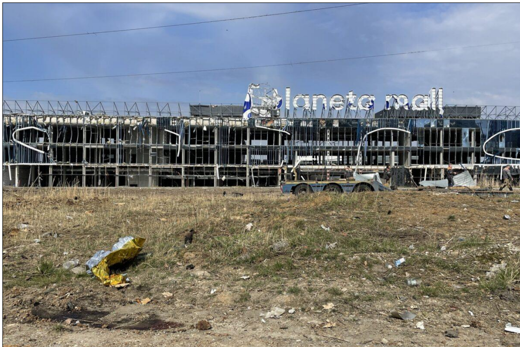
Рис. 2.7. Зруйнований торговельний центр Planeta mall внаслідок влучання балістичної ракети С-300 6 квітня 2024 року [19]
