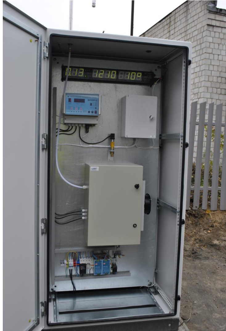
Рис. 2.2 – Стационарний пост спостереження за станом атмосферного повітря
