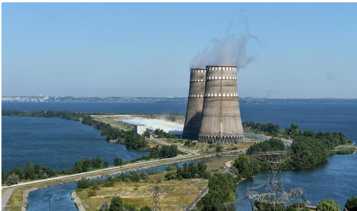
Рис. 1.2 – Водойма-охолоджувач Запорізької АЕС
