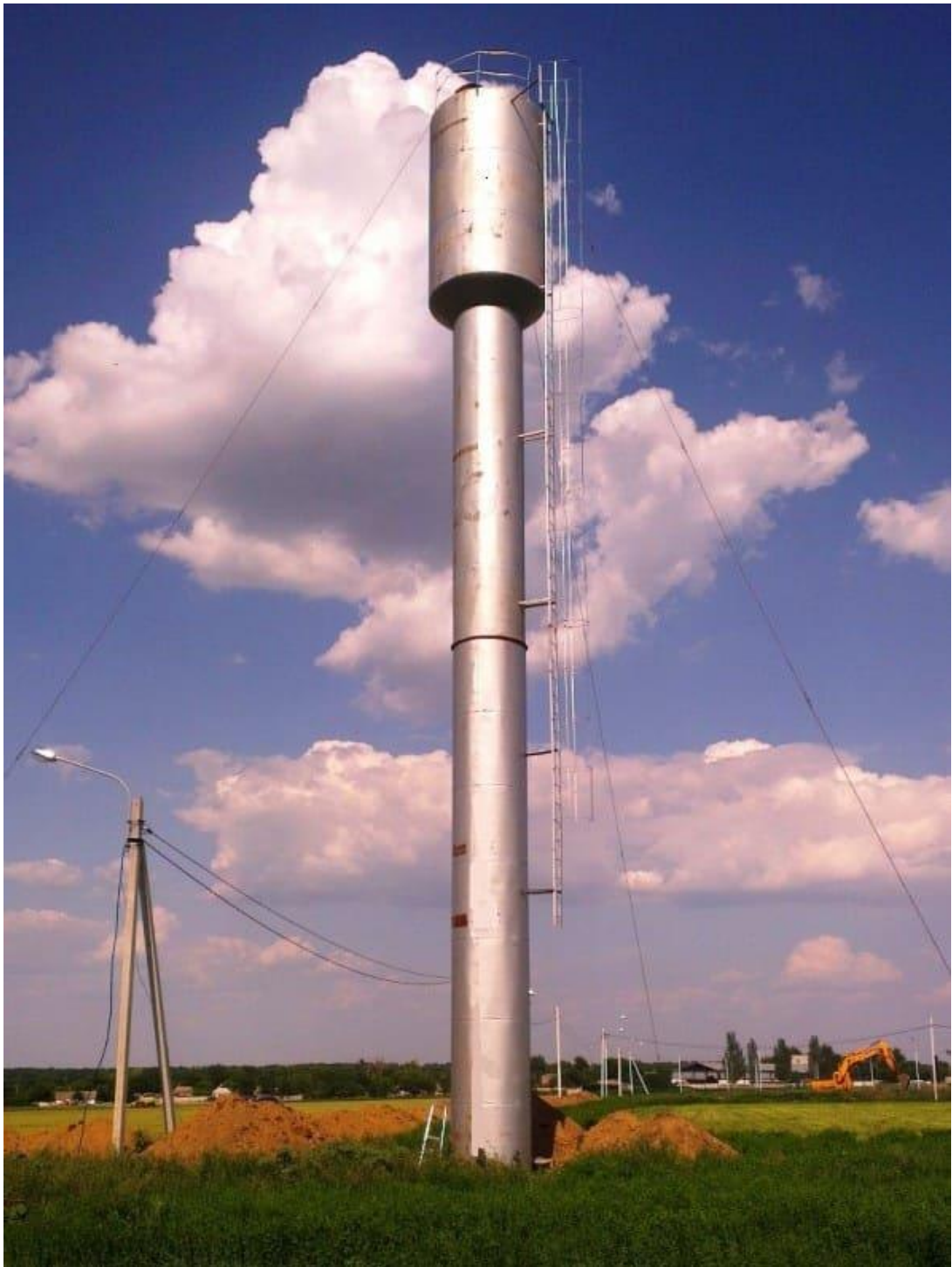
Рисунок 2.6. Зовнішній вигляд водонапірної вежі типового виконання
