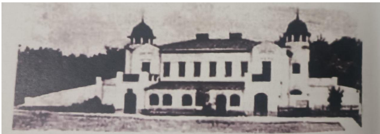
Рис. 13. Будівля господарського двору (дім керуючого). Головний фасад.
