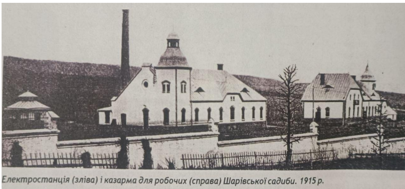
Рис. 12. Електростанція і казарма для робочих
