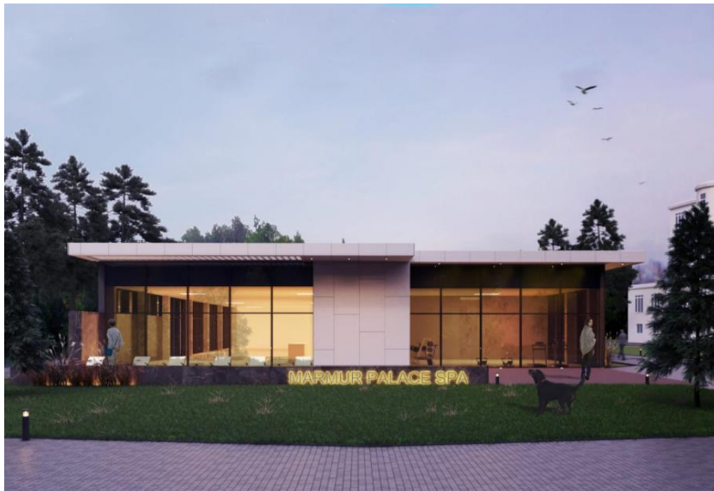
Рис. 3.4 – Зовнішній вигляд східної сторони фасаду будівлі SPA-комплексу санаторію «Мармуровий палац»
