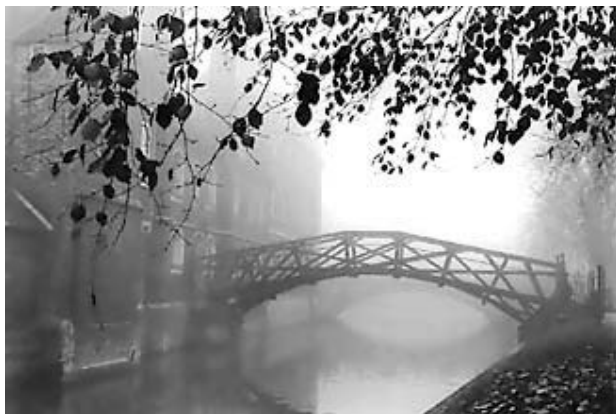
Математический мост — самый старый мост через реку Кем
