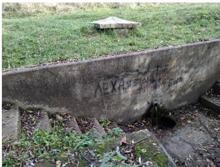
Рис.3.16 – Облаштування каптажу джерела 1 на території смт Буди Харківського району Харківської області
