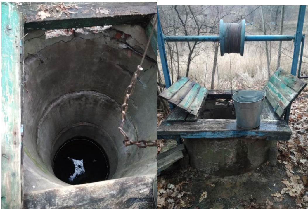
Рис.3.15 – Облаштування шахтного колодязя 4 на території села Верхня Озеряна Харківського району Харківської області
