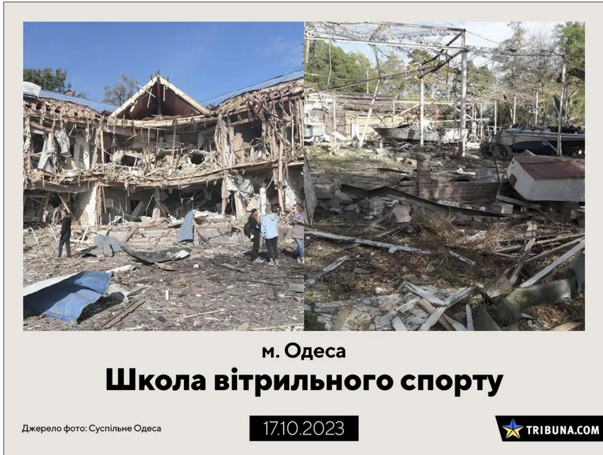
Рис. А.1. Зруйнована школа вітрильного спорту в Одесі [2]
