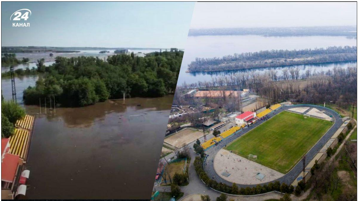
Рис.2.3 затоплений стадіон «Енергія» у місті Нова Каховка [30]
