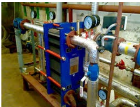
Рисунок 2.1 – Пластинчастий теплообмінник
