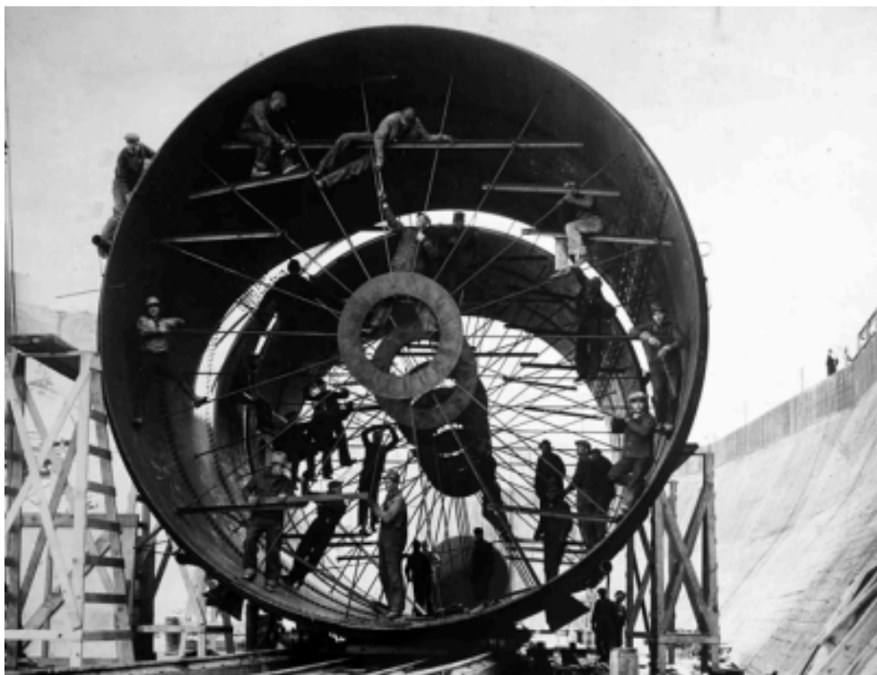
Рис. 3.4 – Маргарет Бурк-Вайт. «Будівництво ГЕС Форт-Пек» (1936) [46]
