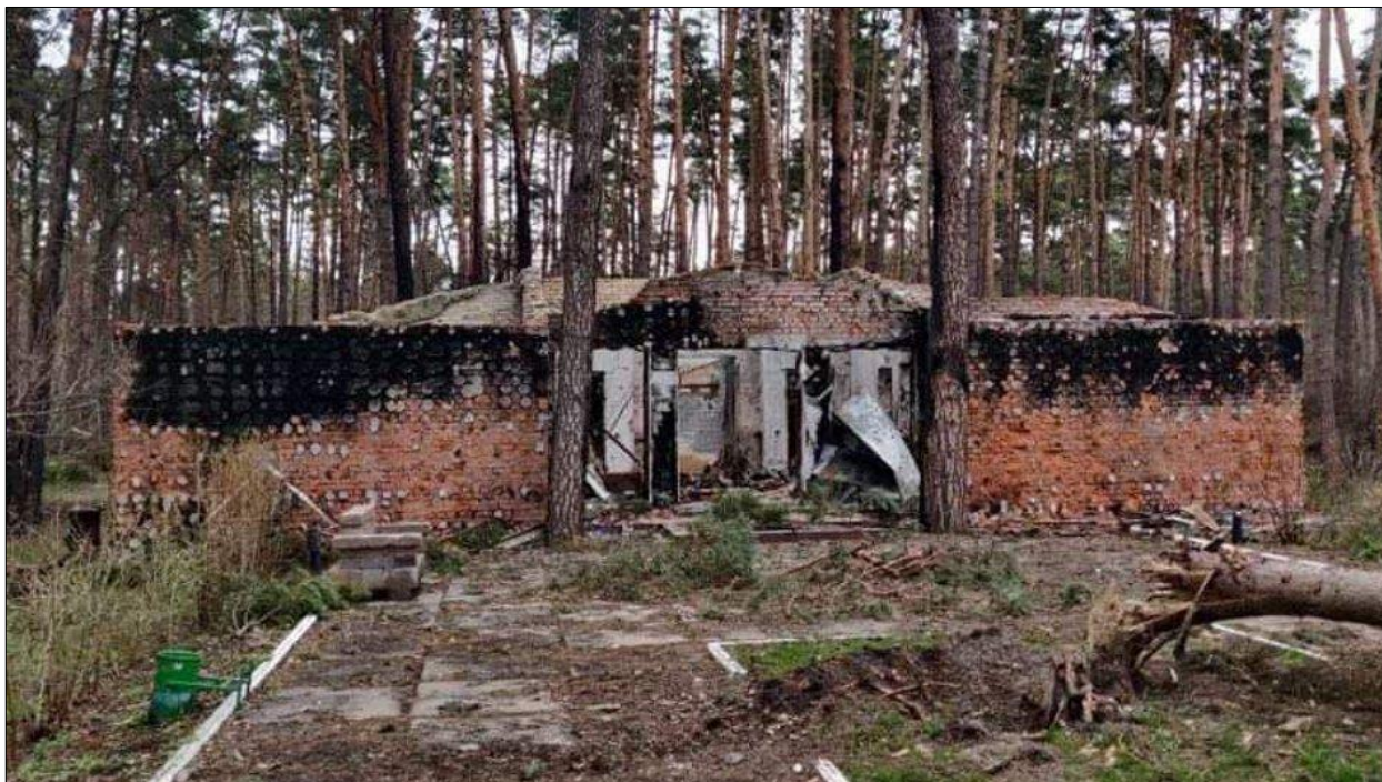
Рис.2.2 Зруйнований центр підготовки Федерації тенісу України в Ірпені [7]
