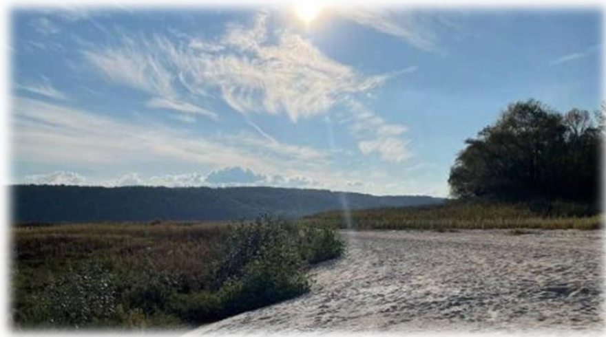
Рис. 3.2. Обміліле Оскільське водосховище після підриву дамби [15]
