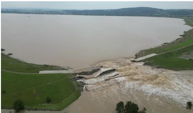
Рис. 1.5. Прорив (в наслідок повеней) дамби біля польського міста Пачкув, 2024 рік [41]
