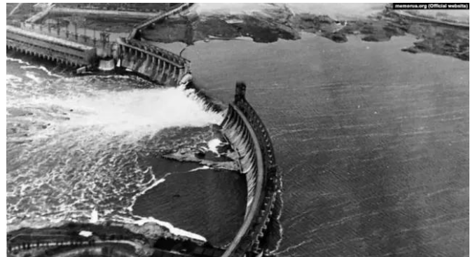
Рис. 1.6. Прорив (в наслідок підриву) частини греблі ДніпроГЕС, 1941 рік [42]
