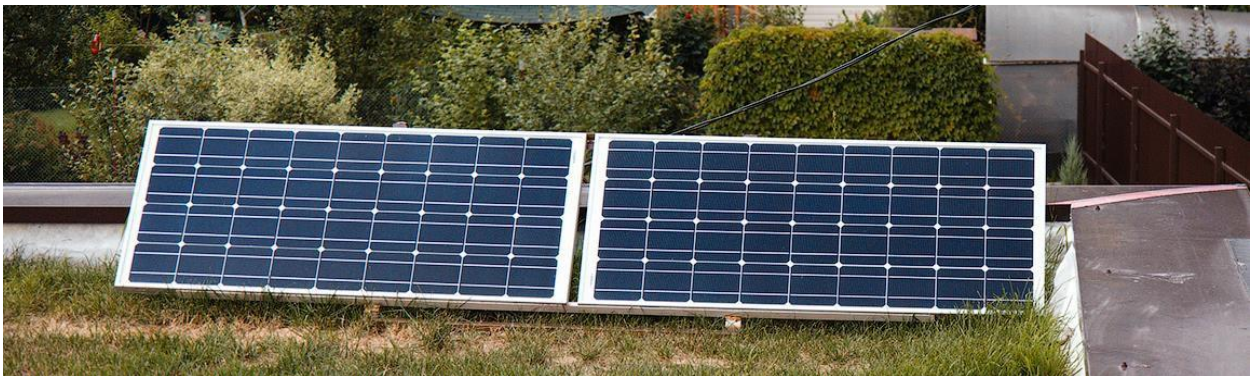
Рисунок 1.3 – Приклад невеликої сонячної електростанції з виробітком 3,1 кВт·год на добу
