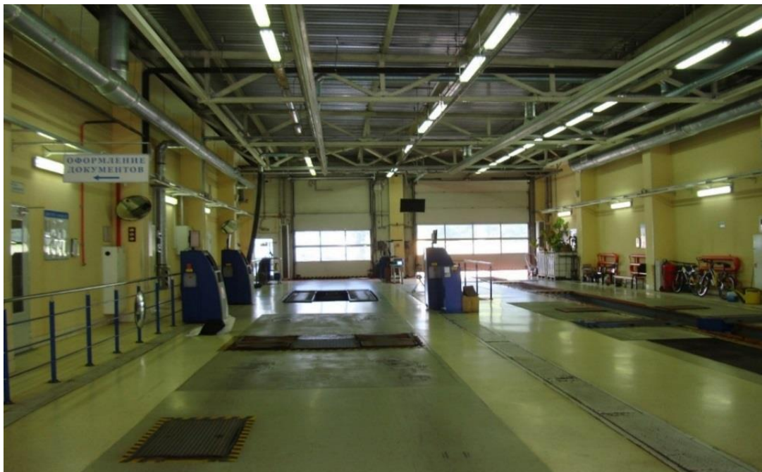
Рисунок 3.1 - Станція технічного обслуговування Центра «Автоексперт» із силовим роликовим гальмовим стендом IW 7 Eurosystem
