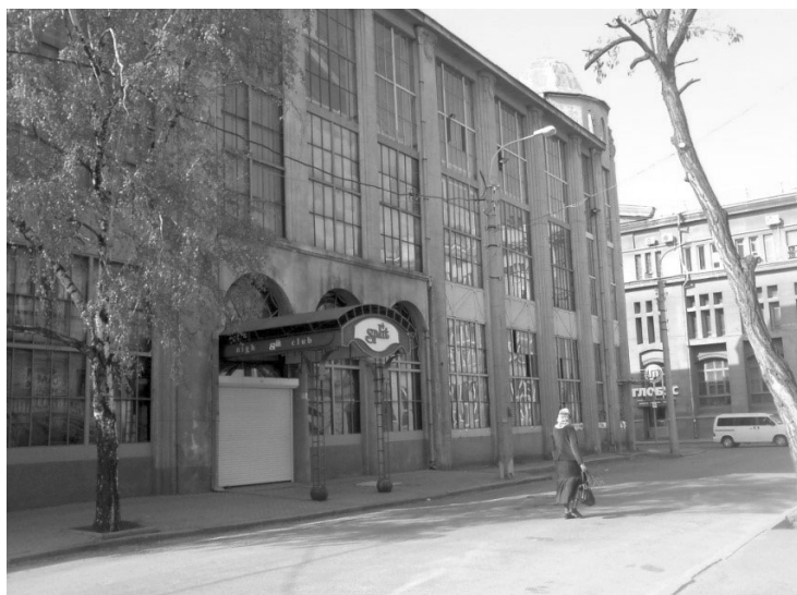
Рис. 2. Вид на здание со стороны Лопанского переулка
