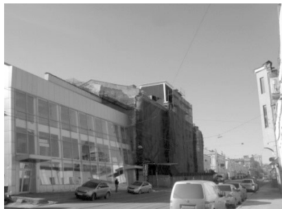
Рис. 10. Реконструкция торцевой стены
